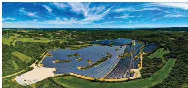
La centrale solaire de Picarreau, la plus vaste de Franche-Comté. Crédit photo : Corsica Sole .
