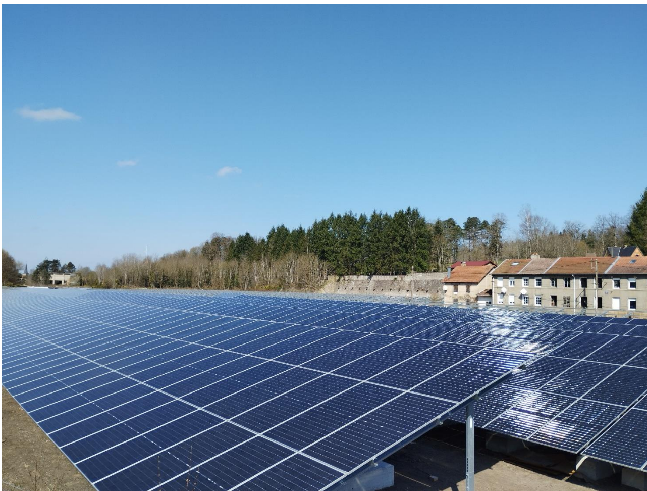
Centrale solaire Corsica Sole de Cirey-sur-Vezouze (en cours de construction)
