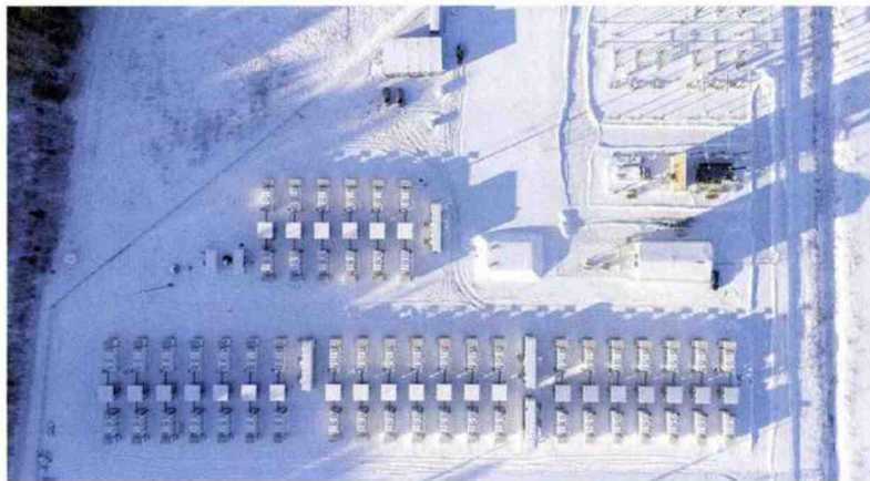
Implantée en Estonie, la centrale de stockage Hertz 1 marque une étape décisive pour la stabilité énergétique des pays baltes. © Corsica Sole
