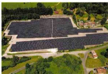
La centrale photovoltaïque de Cirey-sur-Vezouze, située en Meurthe-et-Moselle. © Corsica Sole
